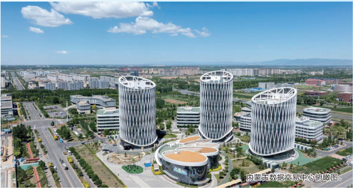
内蒙古能源集团金山第三热电有限公司全景。
