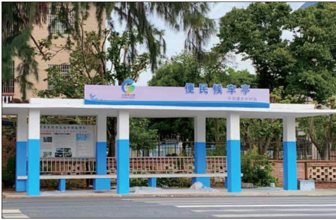
翻新升级后的便民候车亭。(北海城区公路养护中心供图)
