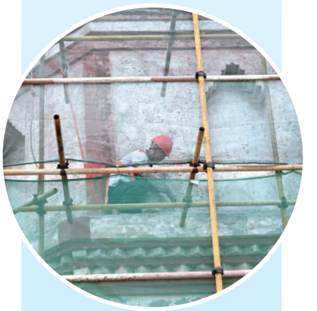
施工人员在“高空绣花”。 何美 摄
