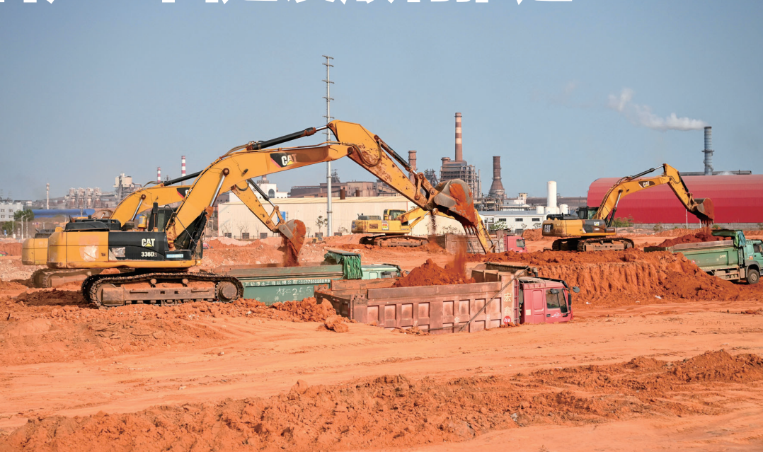
北海建滔绿色新材料产业园项目施工现场。
