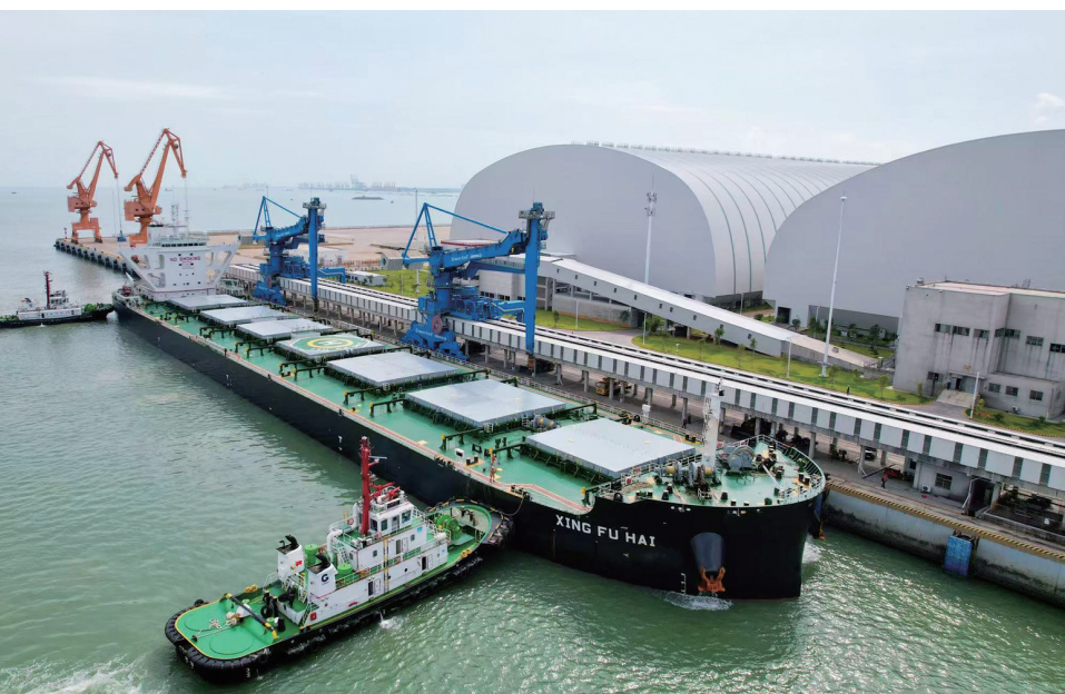
国能码头通关作业现场。（市商务局供图）
