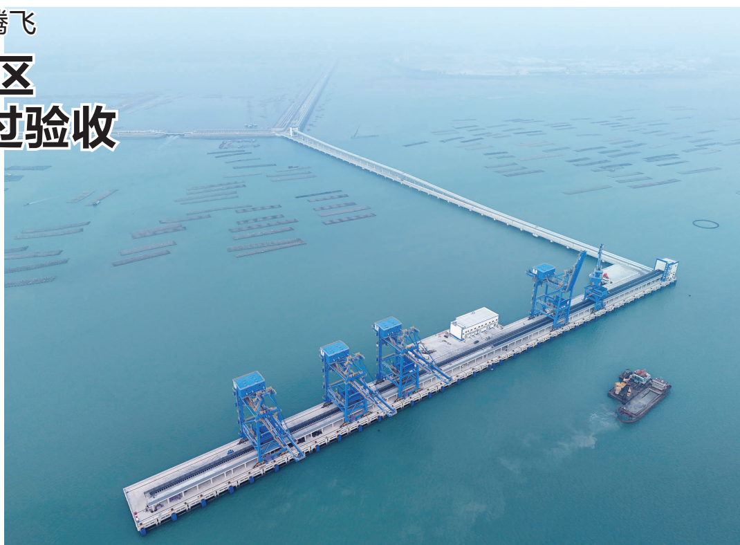
通过验收的北海港铁山港西港区石头埠作业区8号、9号泊位工程项目。 吴一凡 摄
