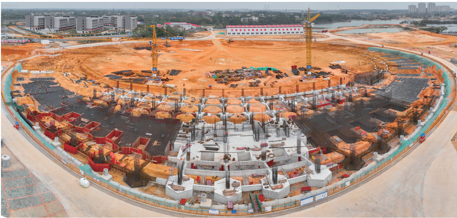
中国东盟(北海)体育实训基地项目建设现场。 李君光 摄
